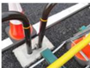
地点6 右折後 柵の支柱土台
