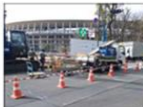
地点5_工事中・路面鉄板敷き
